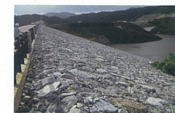
沖縄県にあるロックフィルダム
